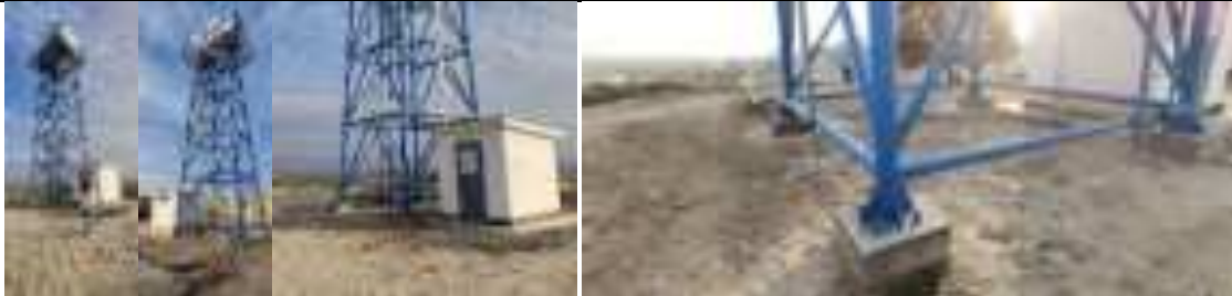
Фото IV 1: ОНТ, передающий трубопровод и установка обратного осмоса (в малом помещении) (27.11.2023)
