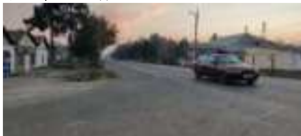
Пересечение подъездной дороги к шоссе
