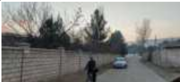
Подъездная дорога в хорошем состоянии
